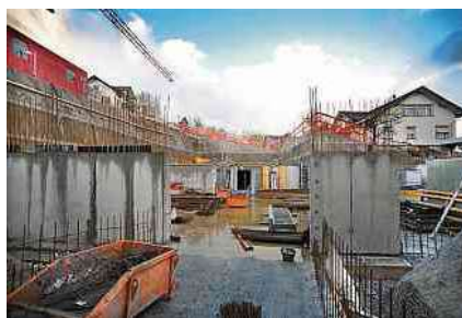
Hier entsteht die neue Gemeindeverwaltung.
